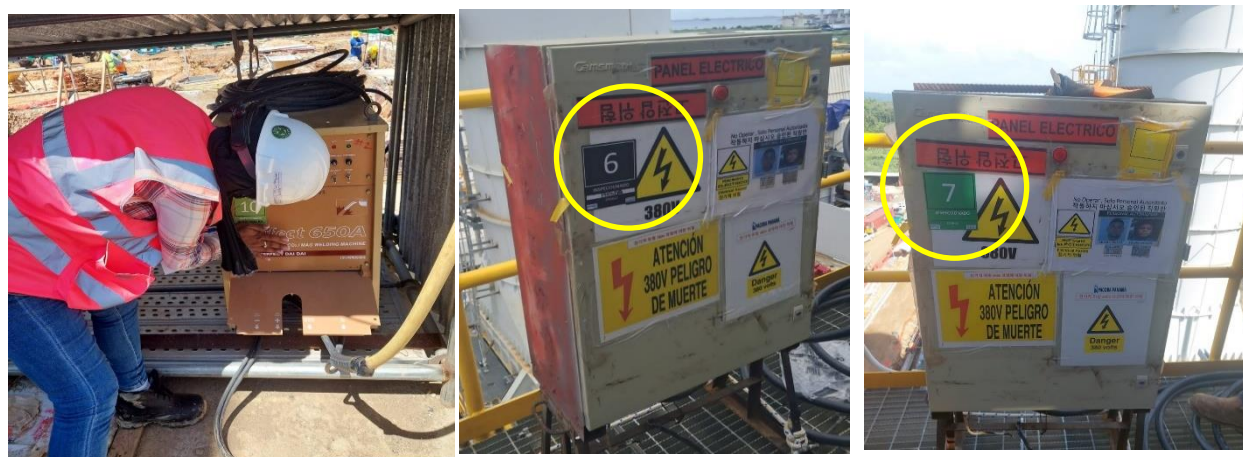
Figura N° 7: Inspección de equipos en campo. Fuente: Autoría Propia.
