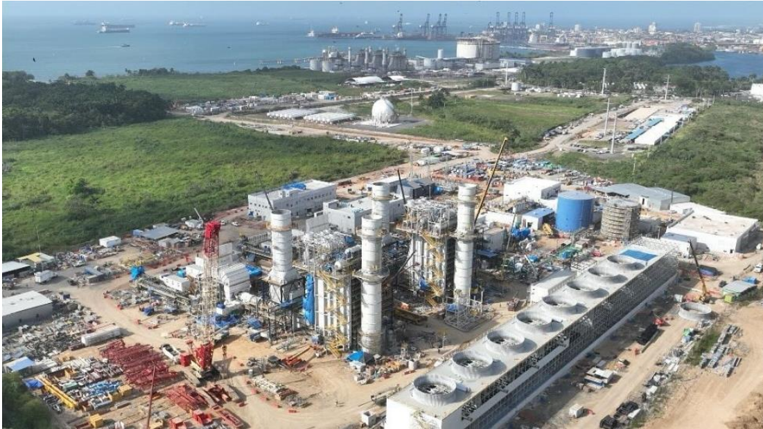
Figura N° 10: Proyecto de Construcción termoeléctrica ciclo combinado Generadora Gatún. Fuente: AES Panamá.
